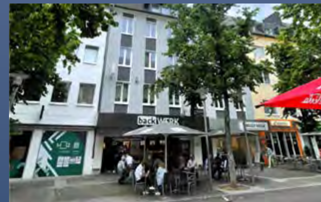
Wohn- und Geschäftshaus Hagen Saniert, Vermietet, Verkauft!
