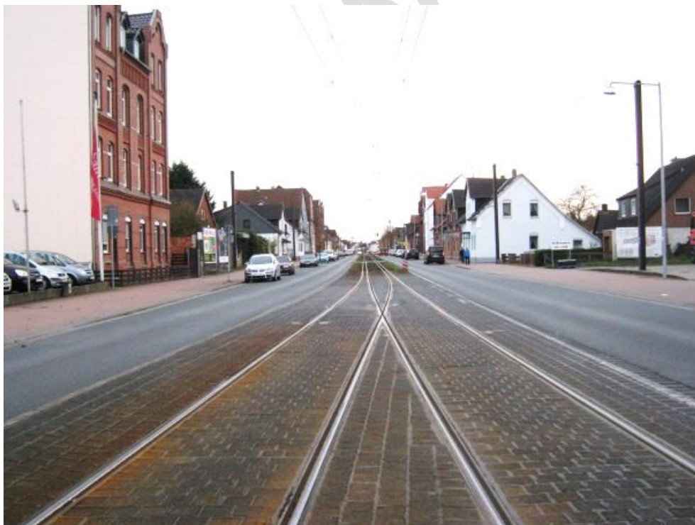
Foto 3.6: Eingleisige Streckenführung in Grasdorf
