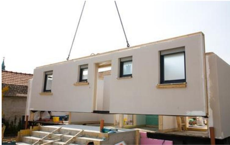
Fertigbauteil der Massivbauweise
