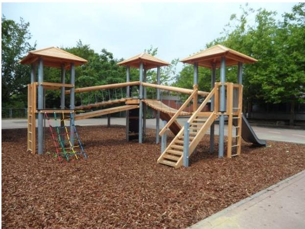
Konstruktion aus Stahlpfosten, damit eine lange Lebensdauer gewährleistet wird.
